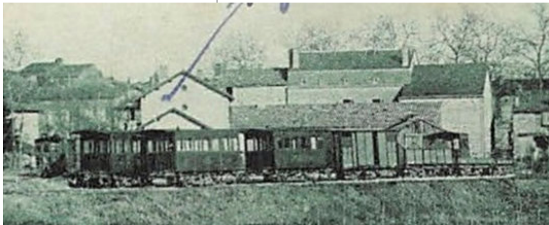
Ce détail d'une photo (voir page suivante) du site de Caussade permet de voir toute la série des wagons du tramway : voyageurs fourgon, tombereau, plate-forme
